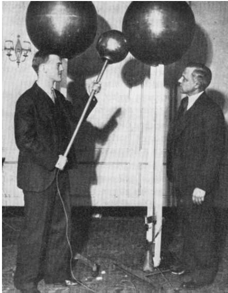
Bild 9. Robert van de Graaff till vänster demonstrerar sin 1,5 MV apparat för Karl T. Compton 1931. (Fig 7 NIM 122)
