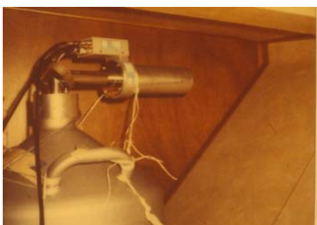
Ett unikt foto av experimentuppställningen under däck i kustbevakningsfartyget Tv 103 tagit av Ragnar Hellborg. Vi ser gammadetektorn och dess elektronik placerad i en koj i en hytt under däck och nära fartygets för.
